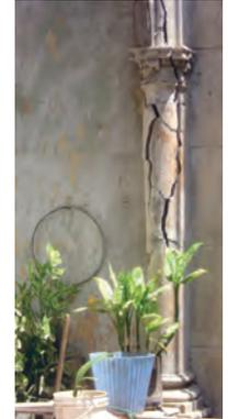
muros iban revestidos de morteros de arena y cal, con proporción 1:2, que en algunos casos adicionaban un 10 % de cemento. Excepcionalmente aparecen columnas de hierro fundido y de sillares de piedra. Posteriormente se comienzan a generalizar los muros de ladrillo y bloques.
